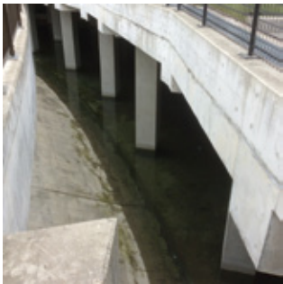
▲調節池 上が公園になっている。大雨が降ると一時雨を溜めておく ◀川沿いの生垣。道路側から川が見えず危険!
