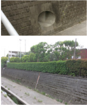
▼大雨の時に川に下水が流れこむところ
